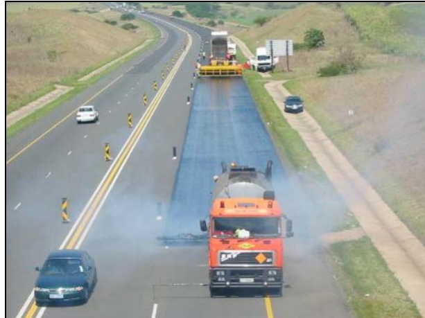
Gambar 1. Pelaksanaan Pekerjaan Chip Seal
