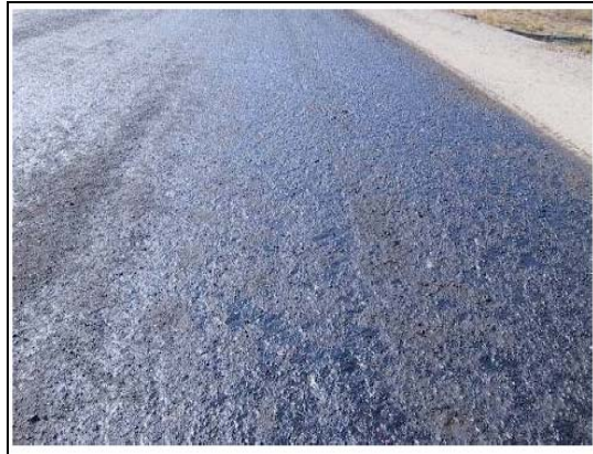
Gambar 6. Kondisi Permukaan Lapis Pondasi yang Sudah diberi Prime Coat
