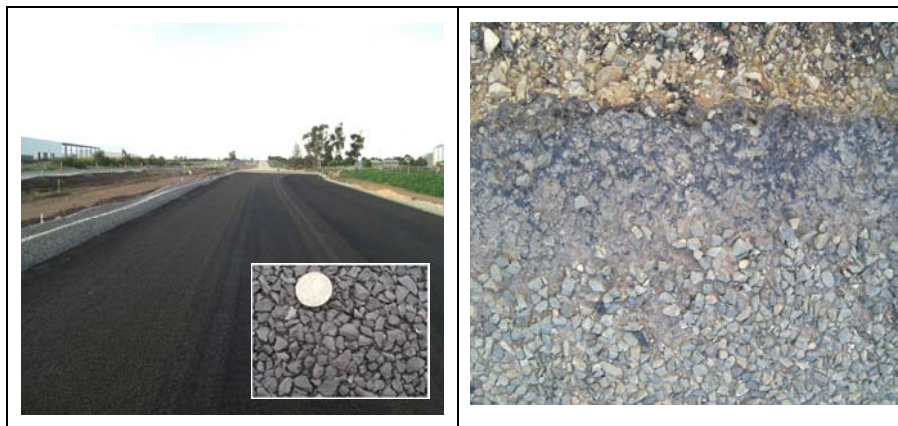
Gambar 7. Primeseal di Atas Lapis Pondasi
