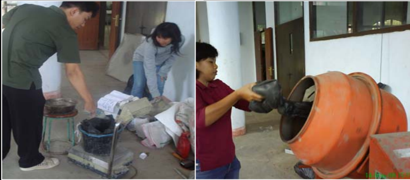
1. Penimbangan dan Pengecoran Bahan
