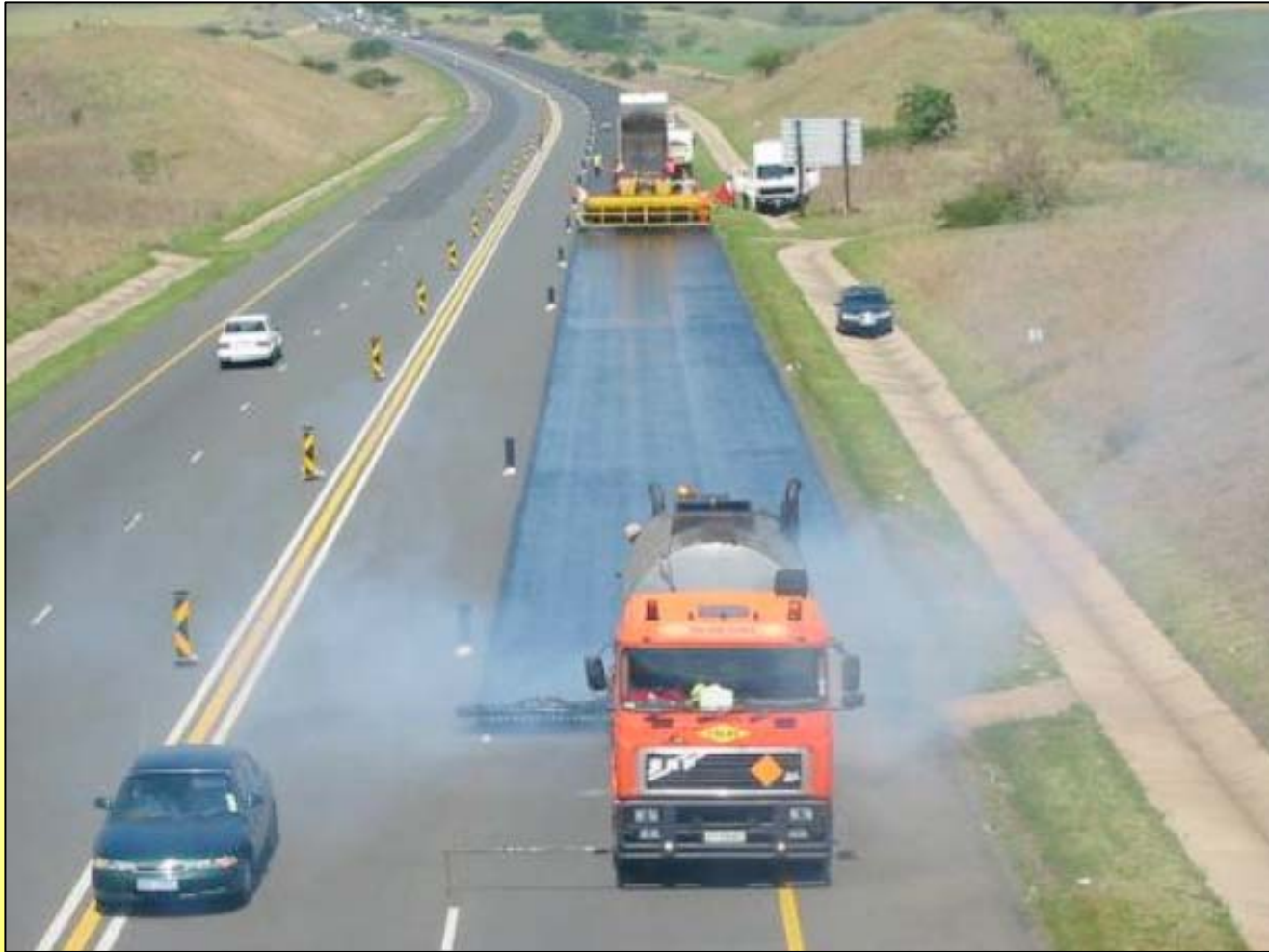
Pelaksanaan Pekerjaan Chip Seal
