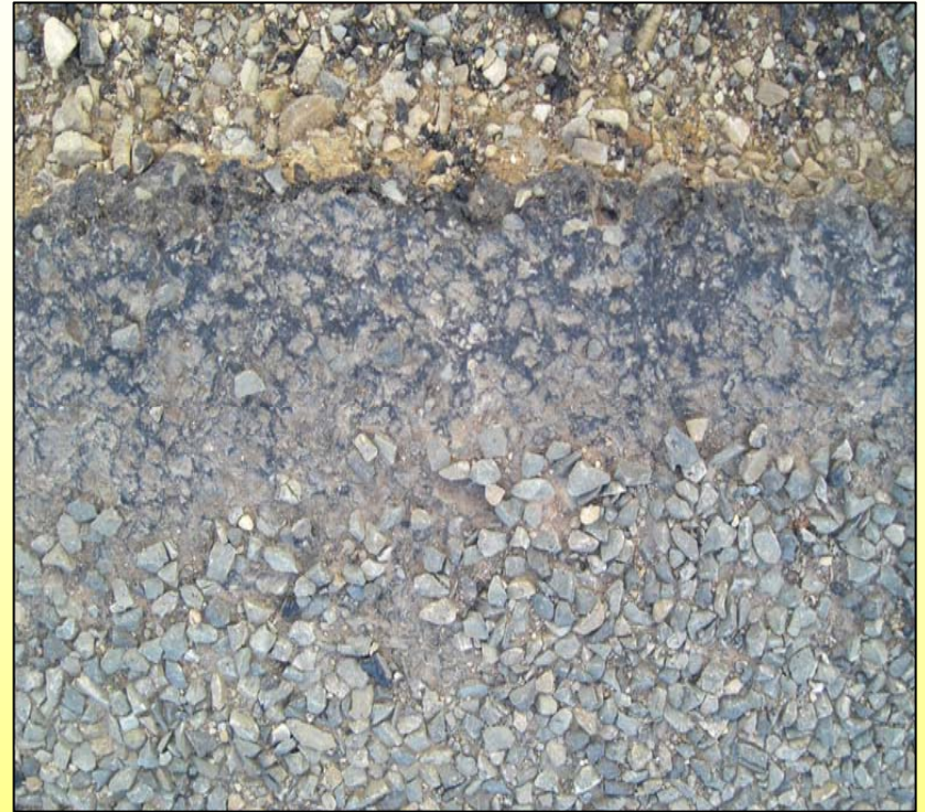
Prime seal di Atas Lapisan Pondasi
