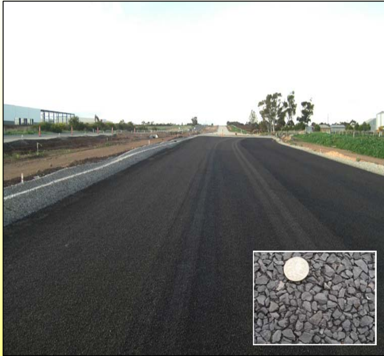
Prime seal di Atas Lapisan Pondasi
