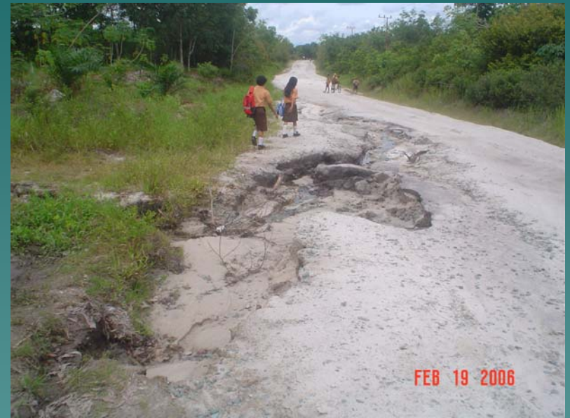
b. Perkembangan Kinerja Lapis Pondasi Agregat-Pasir Kuarsa Dalam Dua Minggu Akibat Air
